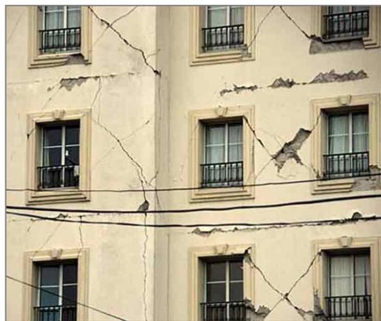
**Figura 2.2 - Fendilhação diagonal em paredes de alvenaria após um sismo (Renois, 2010)**
