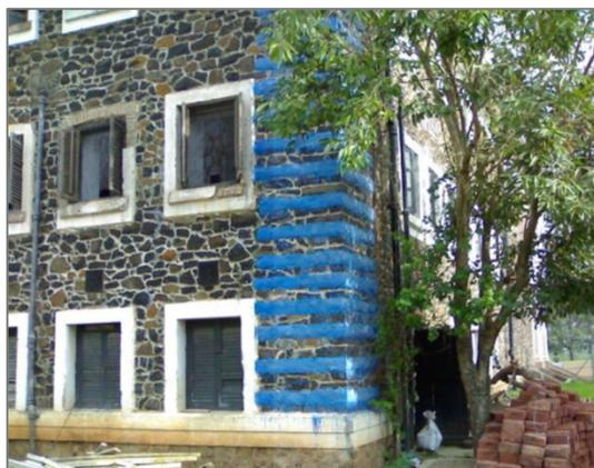
**Figura 3.10 - Utilização de FRP no confinamento de um pilar de canto (Firmo, 2016)**
