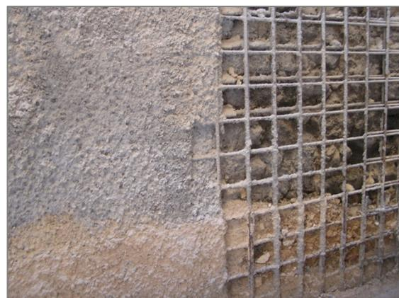
**Figura 3.5 - Utilização do reboco armado na reabilitação e reforço de um edifício na Avenida da Liberdade, Lisboa (Sierra, 2012)**
