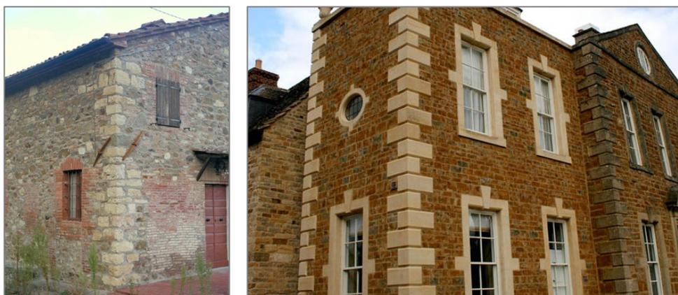
**Figura 3.1 - Utilização de elementos de cantaria de maior dimensão e de ancoragens exteriores na ligação entre paredes ortogonais (Diane, 2014), (CHR, 2016)**
