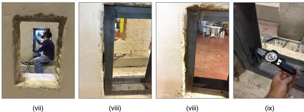
**Figura 5.13 - Montagem da solução de reforço II**
