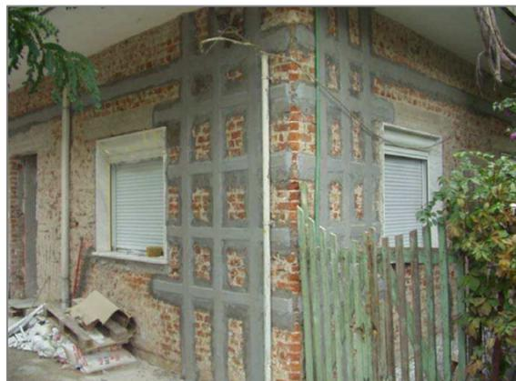
**Figura 3.9 - Utilização de FRP para reforço a cargas perpendiculares ao plano da parede (Islam, 2008)**
