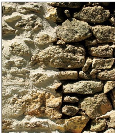
**Figura 3.12 - Aplicação da REABILITA RJ 35 no refechamento de juntas (Secil A. , 2016)**
