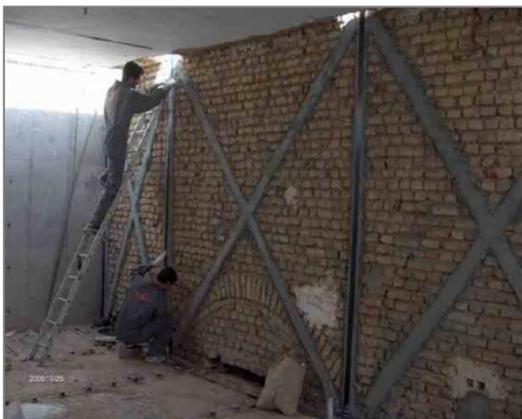
**Figura 3.8 - Utilização de FRP para reforço a cargas no plano da parede (Islam, 2008)**
