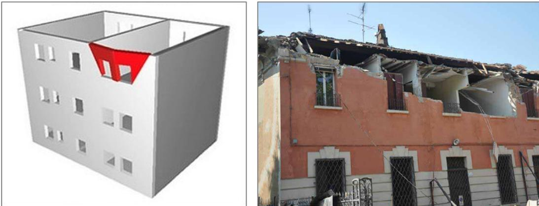
**Figura 2.5 - Colapso de uma parede de alvenaria por flexão horizontal (Maione, 2016), (Sisma, 2012)**
