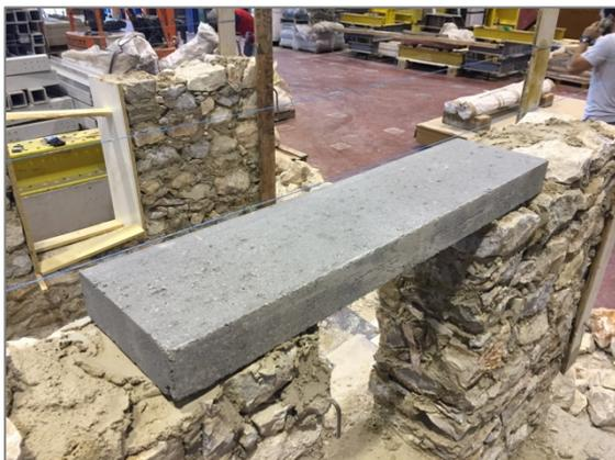
**Figura 5.3 - Colocação do lintel no topo da abertura**
