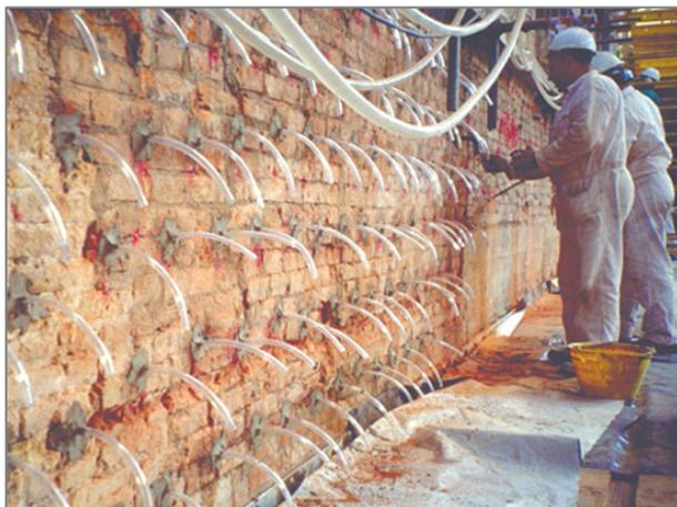
**Figura 3.7 - Reforço de uma parede do Teatro la Fenice através da injeção de caldas (Resinproget, 2016)**
