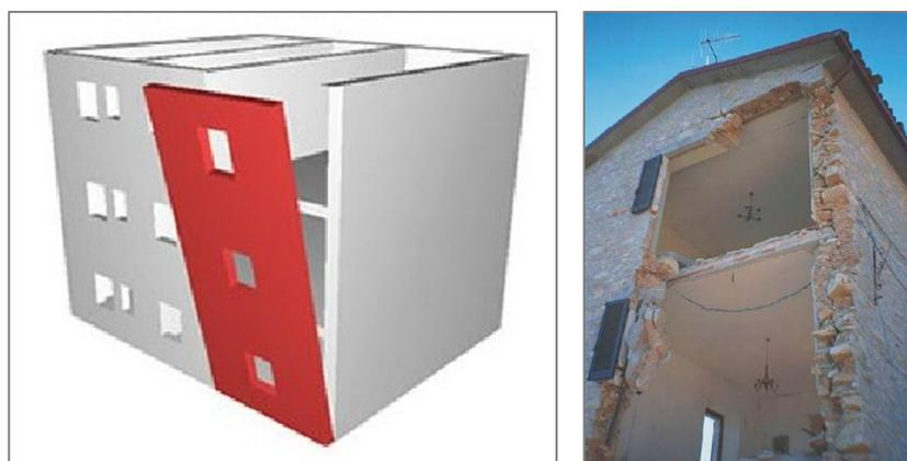
Figura 2.4 - Colapso de uma parede de alvenaria por derrubamento simples (Maione, 2016), (Blasi, 2004)
